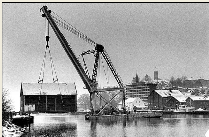
Det var noen nervepirrende minutter da Riggeloftet ble flyttet med kran fra Kaldens til Kystkultursenteret. Foto: Vestfoldarkivet
