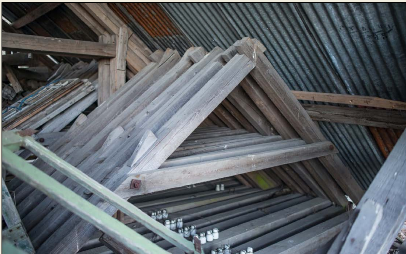
De originale konstruksjonene fra Reperbanen er bevart og vil utgjøre et viktig visuell element i bygget . Foto: Runar Tveiten
