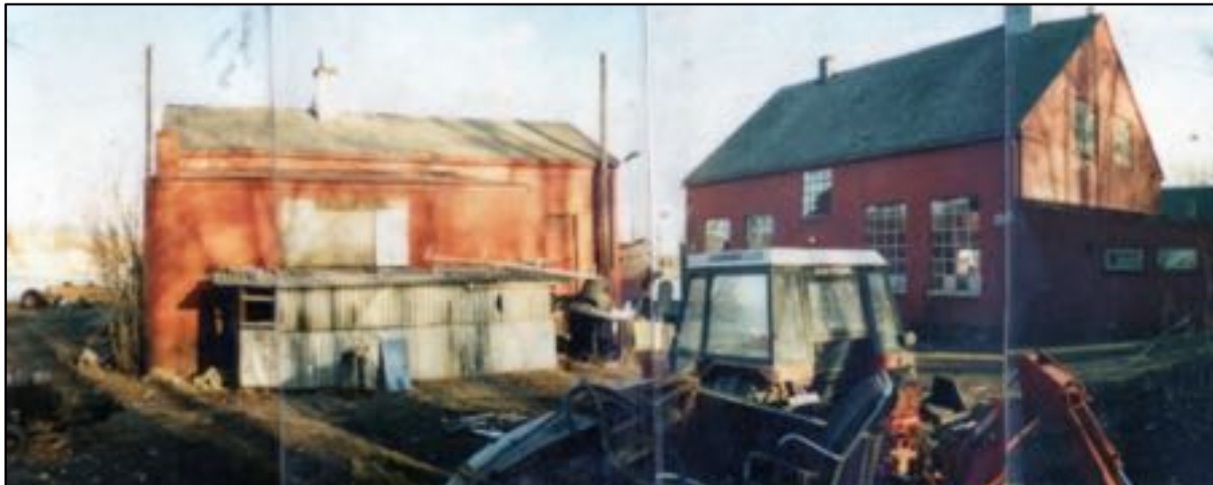
Teie Ubåtstasjon var klar for rivning da Stiftelsen Teie ubåtstasjon i 1992 klarte å redde bygningene fra anleggsmaskinenes "klør".
